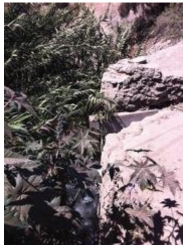
Figura 3.16 Vista 2 del sector Bodega
