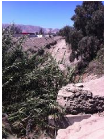
Figura 3.15 Vista 1 del sector Bodega
