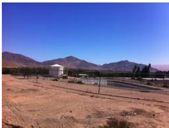
Figura 3.17 Vista de la Planta de Tratamiento de Aguas Chañar y el Estanque de Candelaria
